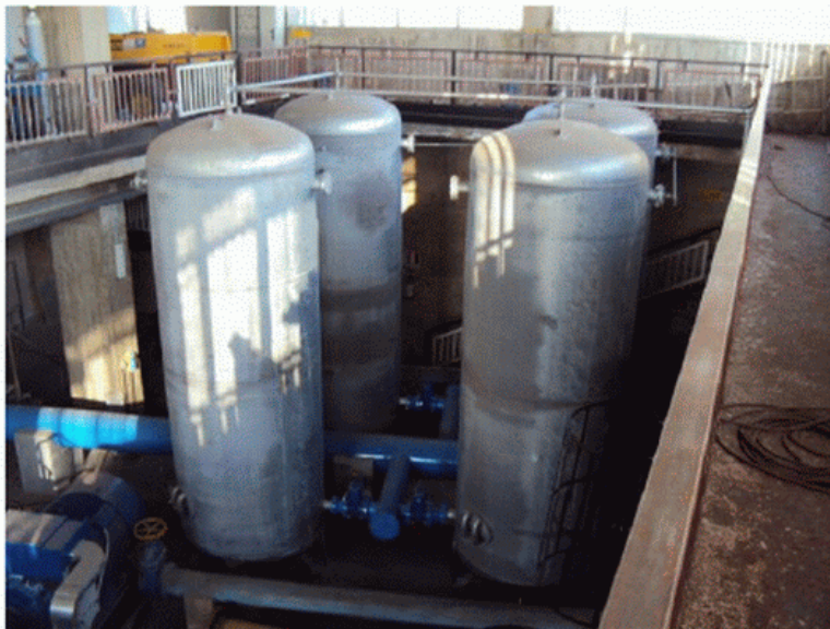
La foto mostra le casse d'aria dell'impianto di sollevamento dell'Acquedotto Pugliese presso il Comune di Seclì, in provincia di Lecce. Il dispositivo è stato realizzato per minimizzare le eventuali sovrappressioni nella rete in fase di arresto contemporaneo delle elettropompe per stacco brusco della forza motrice. Si tratta di 4 casse d'aria, ciascuna della capacità di 9,5 \text{ m}^3 per una pressione di esercizio di 16 \cdot 10^5 \text{ Pa} .
