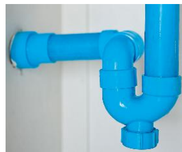
Figura 4 Raccordi in plastica di cloruro di polivinile (PVC).
