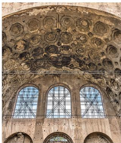
↑ 29 Volta con cassettoni ottagonali e quadrati nella Basilica di Massenzio, Roma.
