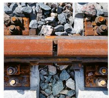
**FIGURA 20** Le giunzioni delle rotaie presentano degli spazi per evitarne la deformazione dovuta alla dilatazione lineare.
